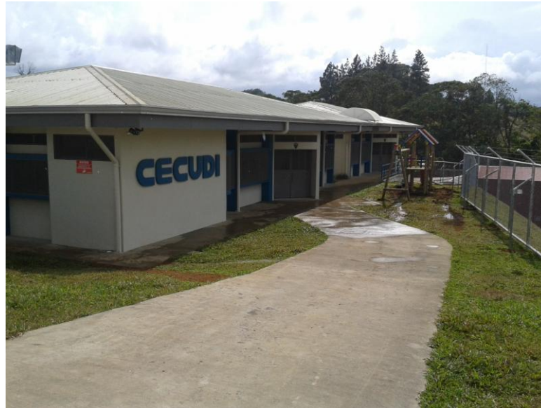
Vista costado noreste del Edificio
